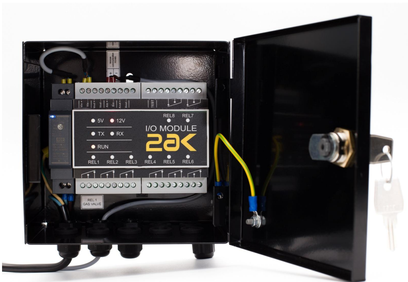
Widok wewnątrz modułu przekaźnikowego
